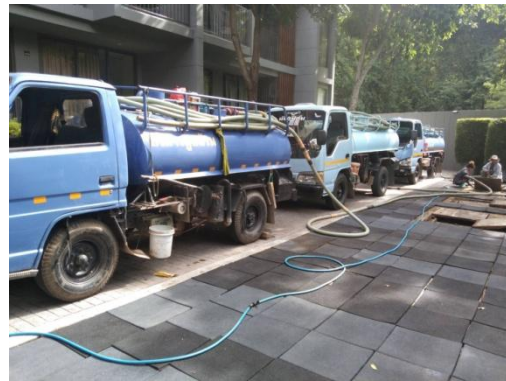
สูบน้ำจากระบบบำบัดน้ำเสียไปกำจัด
